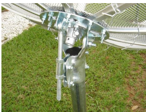
Fixação da Antena no Tubo
