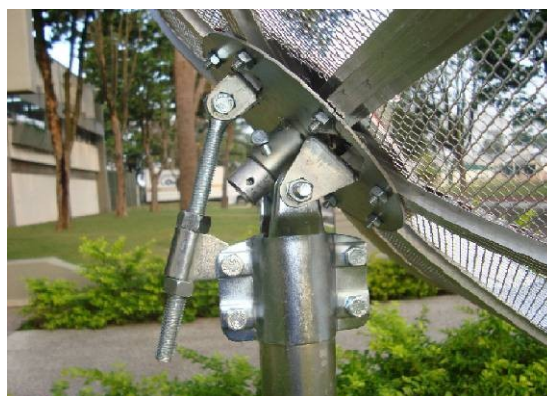
Fixação da Antena no Tubo
