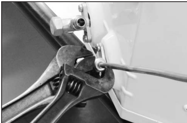
FIG. 31 - FIXAÇÃO DA PORCA
