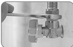
6. Rosqueie a mangueira metálica no registro de gás com o auxílio de duas chaves de boca. Utilize pasta vedante para auxiliar na vedação. O ponto de abastecimento de gás tem que permitir a instalação da mangueira flexível metálica de maneira que ela fique paralela a parede evitando-se assim um estrangulamento.
