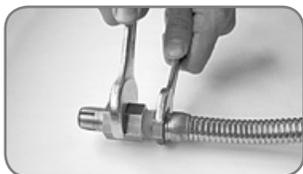
2. Faça a fixação com auxílio de duas chaves de boca.
