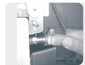
Encaixe a mangueira na conexão de gás
