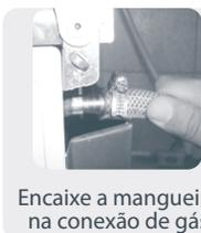
Encaixe a mangueira na conexão de gás
